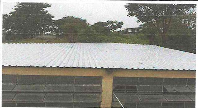
Foto 3: Sustitución de lamina existente (cocina) por lamina troquelada aluzinc calibre 26
