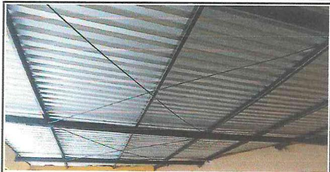
Foto 2: Mantenimiento de estructura de soporte de metal (costaneras de cocina) lijado, cepillado y aplicación de pintura.
